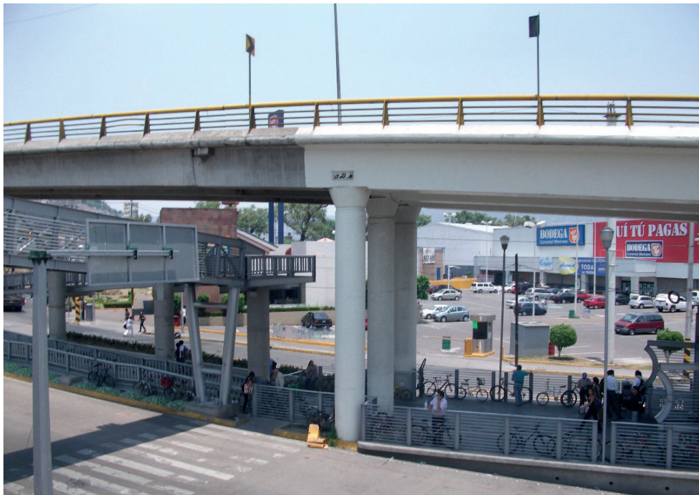
Figura 4. Vista de la entrada a la estación del BRT Tenayuca (Mexibus, Línea 3, Ciudad de México)
