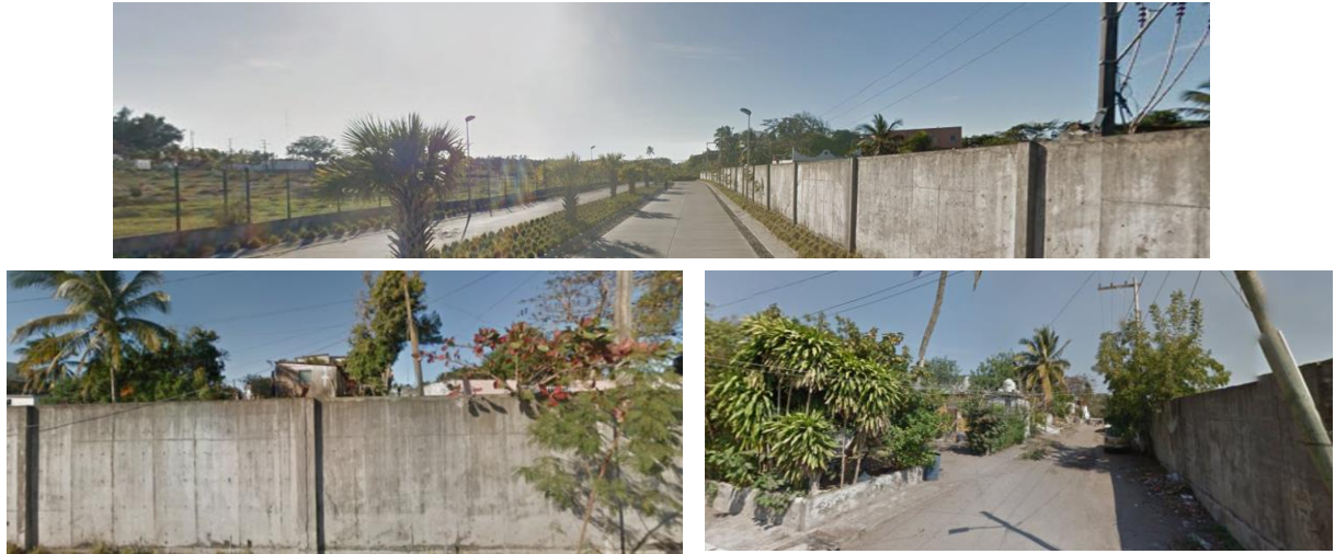
Figura 4.4. [Fotografías Propias]. Arriba Barda que divide pueblo El Conchal (lado derecho) y Club de Golf "La Villa Rica" (lado izquierdo); abajo izquierda Barda en El Conchal y abajo derecha Entrada a El Conchal con camino de terracería.
